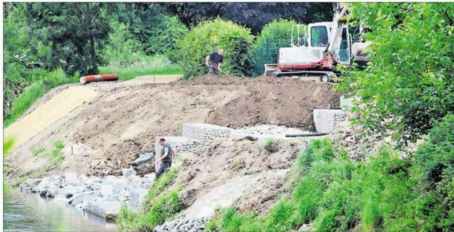
Die Bauarbeiten an der Innerste schreiten voran. Anfang September soll der Rastplatz fertig sein.
